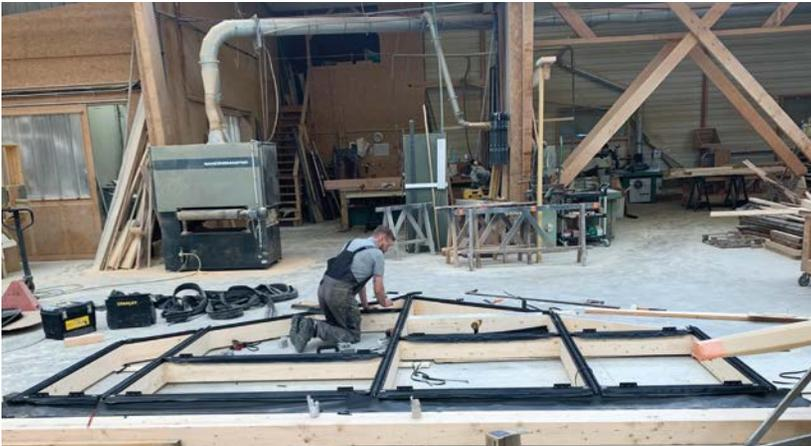
Fabrication du système du mur rideau à l'atelier en structure bois lamellée collée et finition aluminium extérieure.
