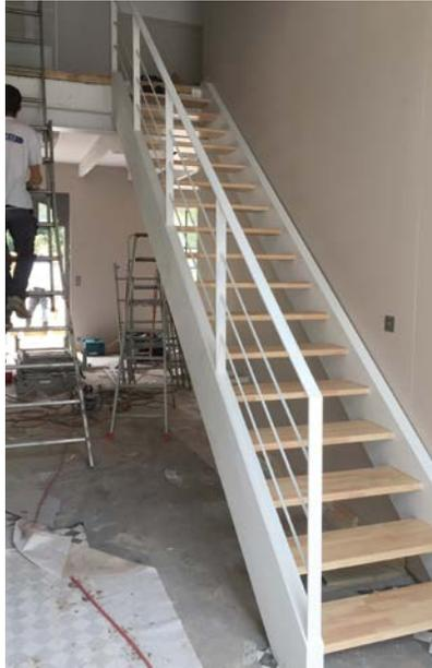
• Pose d'un escalier (1/4 tournant bas hors standard en Hevea, avec contremarches, garde-corps métalliques et tubes inox) selon le plan d'architecte.
