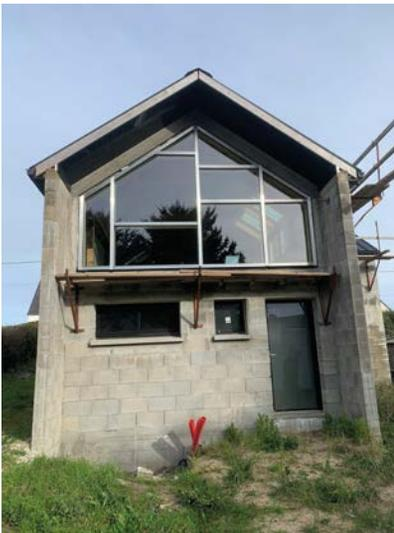
• Pose de l'ensemble menuisé et des vitrages. Finition par capots aluminium.
