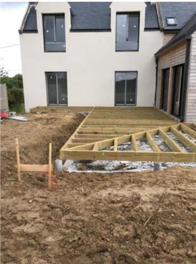
• Pose des plots bétons et des poutres en pin.
