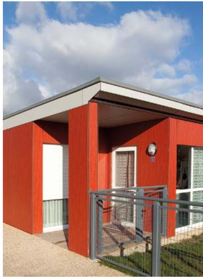
Les menuiseries et l'étanchéité de la toiture ont été réalisés en PVC. Le bardage est en stratifié fundermax. Les murs ont été totalement terminés en atelier intégrant les câblages électriques et le parement intérieur en OSB vernis. On retrouve ici les prémisses du modulaire.
